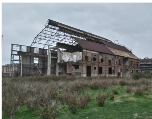
Figura 18 - La centrale termica produceva vapore ed energia dal recupero dei gas ricchi di cokeria e altoforno (Fonte: Invitalia)
