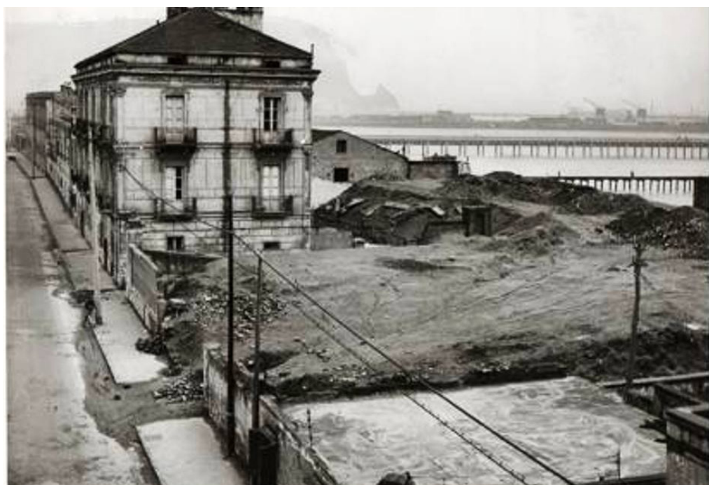
Figura 28 – Foto della costruzione della colmata che evidenzia l'abbattimento delle abitazioni lungo via Coroglio (Fonte: A. Del Vecchio)
