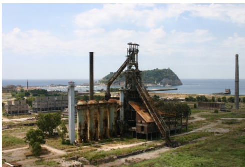
Figura 16 - L'altoforno n. 4 con i suoi percorsi aerei, il suo elevatore inclinato (skip) e il tino per le fusioni (Fonte: Invitalia)
