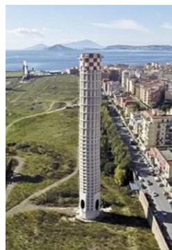
Figura 20 – Candela AGL – smaltiva in quota i fumi dell'impianto di agglomerazione (Fonte: Cristoforoni 2016)
