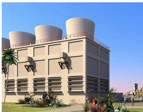
Figura 19 – L'ex Impianto Trattamento acque, doveva essere trasformato in un Turtle Point , un ospedale delle tartarughe (Fonte: Corriere del Mezzogiorno) 16
