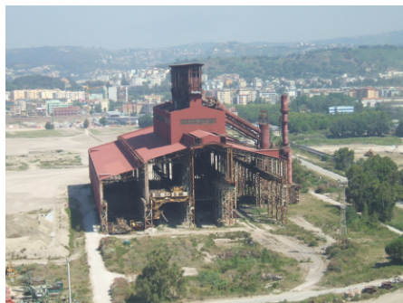
Figura 15 - L'acciaieria conserva intatto uno dei suoi convertitori ad ossigeno, che trasformavano la ghisa liquida in acciaio (Fonte: Invitalia)
